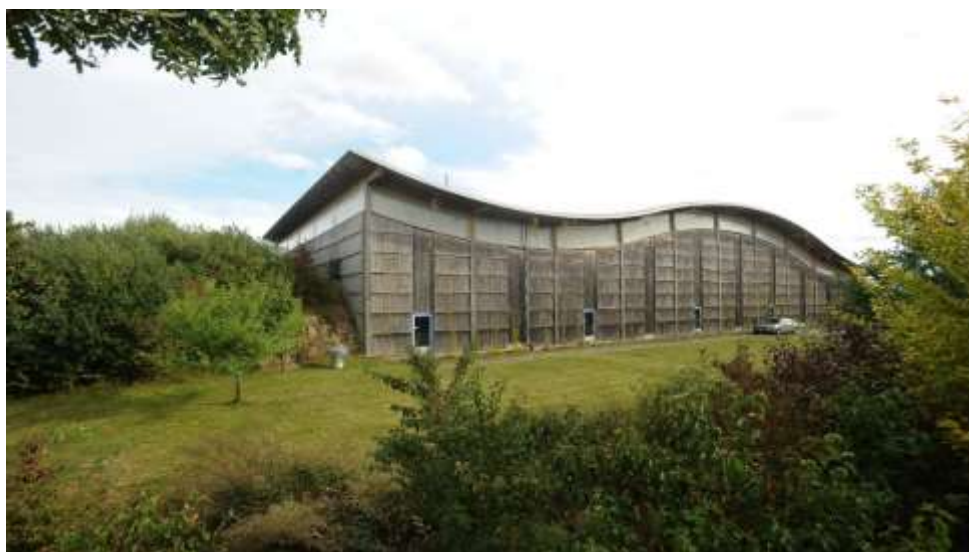
Abb.8: Seitenansicht der in die Landschaft integrierten Logistikhalle 1
